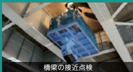
橋梁の接近点検
