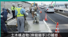
土木構造物(伸縮継手)の補修
