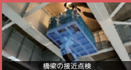
橋梁の接近点検
