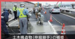
土木構造物(伸縮継手)の補修
