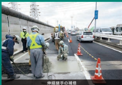
伸縮継手の補修
