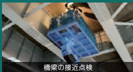
橋梁の接近点検
