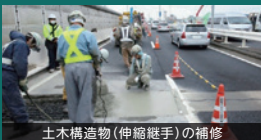
土木構造物(伸縮継手)の補修
