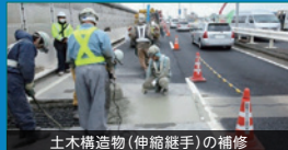
土木構造物(伸縮継手)の補修
