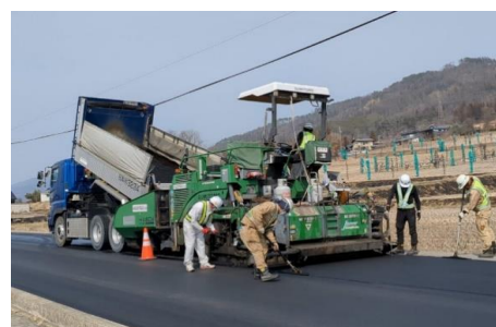
（施工イメージ）
