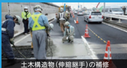
土木構造物(伸縮継手)の補修
