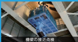
橋梁の接近点検
