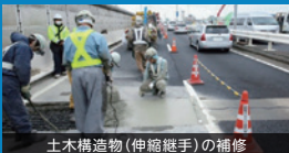
土木構造物(伸縮継手)の補修
