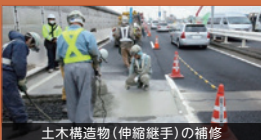
土木構造物(伸縮継手)の補修
