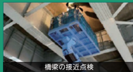
橋梁の接近点検
