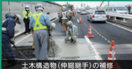
土木構造物(伸縮継手)の補修
