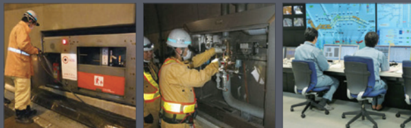
泡消火栓点検
