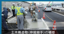
土木構造物(伸縮継手)の補修
