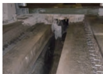
② 橋梁伸縮装置の 撤去後の状況
