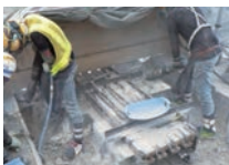
① 既存の 橋梁伸縮装置を撤去
