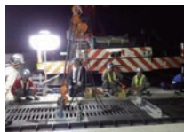
③ 新しい 橋梁伸縮装置の設置
