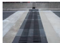
④ 工事完了
