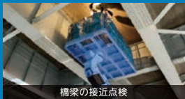
橋梁の接近点検
