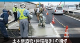
土木構造物(伸縮継手)の補修
