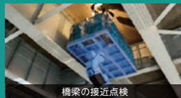
橋梁の接近点検
