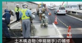
土木構造物(伸縮継手)の補修
