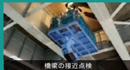
橋梁の接近点検
