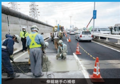
伸縮継手の補修
