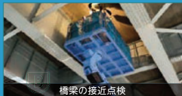
橋梁の接近点検
