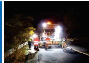
（舗装修繕工事）
