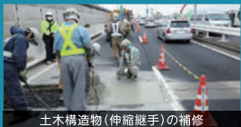
土木構造物(伸縮継手)の補修
