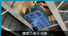
橋梁の接近点検
