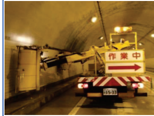
(トンネル内清掃)
