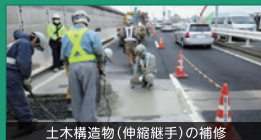
土木構造物(伸縮継手)の補修
