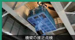
橋梁の接近点検
