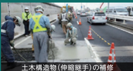
土木構造物(伸縮継手)の補修
