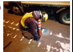
(道路附属物工事)
