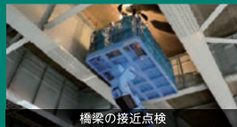
橋梁の接近点検
