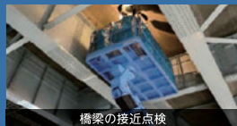
橋梁の接近点検
