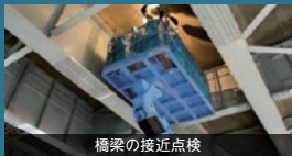
橋梁の接近点検
