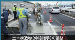
土木構造物(伸縮継手)の補修
