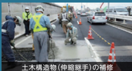
土木構造物(伸縮継手)の補修
