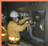
水噴霧装置点検
