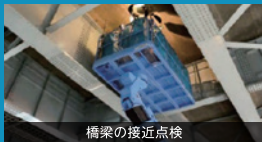
橋梁の接近点検
