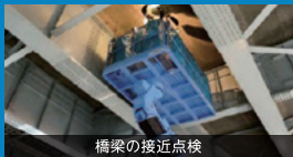
橋梁の接近点検
