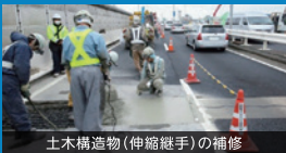
土木構造物(伸縮継手)の補修
