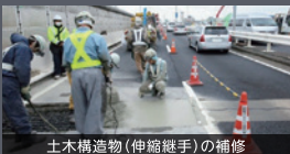
土木構造物(伸縮継手)の補修
