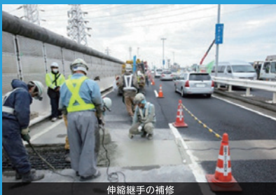
伸縮継手の補修
