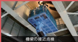
橋梁の接近点検
