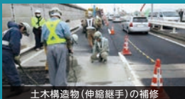
土木構造物(伸縮継手)の補修
