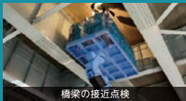
橋梁の接近点検
