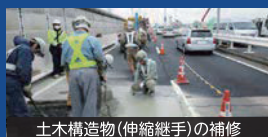
土木構造物(伸縮継手)の補修
