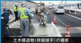
土木構造物(伸縮継手)の補修
