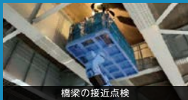
橋梁の接近点検
