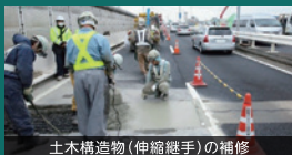
土木構造物(伸縮継手)の補修
