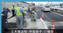
土木構造物(伸縮継手)の補修
