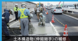
土木構造物(伸縮継手)の補修
