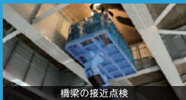
橋梁の接近点検
