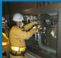
水噴霧装置点検
