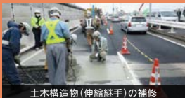
土木構造物(伸縮継手)の補修
