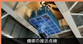
橋梁の接近点検
