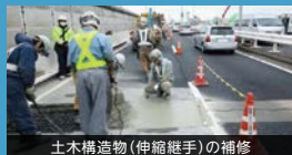
土木構造物(伸縮継手)の補修
