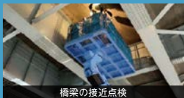
橋梁の接近点検
