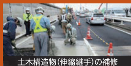
土木構造物(伸縮継手)の補修
