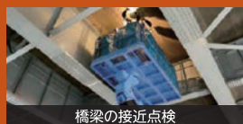
橋梁の接近点検
