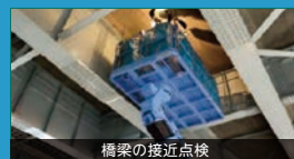
橋梁の接近点検
