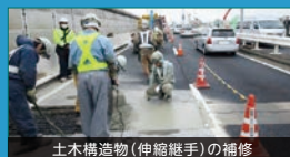
土木構造物(伸縮継手)の補修
