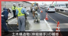
土木構造物（伸縮継手）の補修
