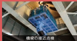
橋梁の接近点検
