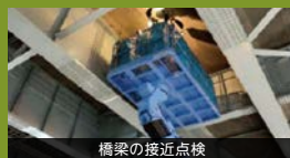
橋梁の接近点検
