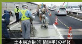
土木構造物(伸縮継手)の補修
