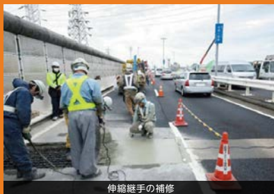
伸縮継手の補修
