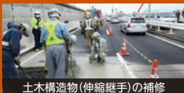
土木構造物(伸縮継手)の補修
