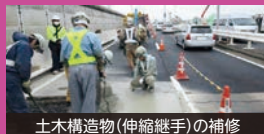
土木構造物(伸縮継手)の補修
