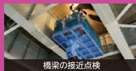
橋梁の接近点検
