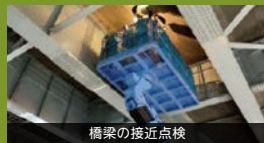
橋梁の接近点検
