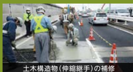
土木構造物(伸縮継手)の補修
