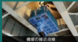
橋梁の接近点検
