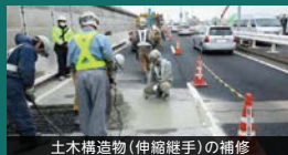
土木構造物(伸縮継手)の補修
